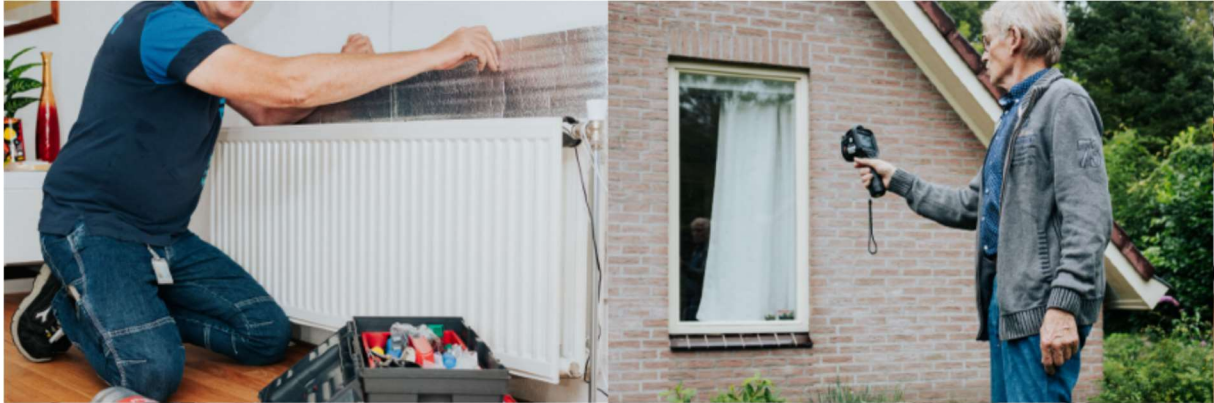
Foto links: fixer plakt radiatorfolie, rechts: energiecoach voert een warmtescan uit
